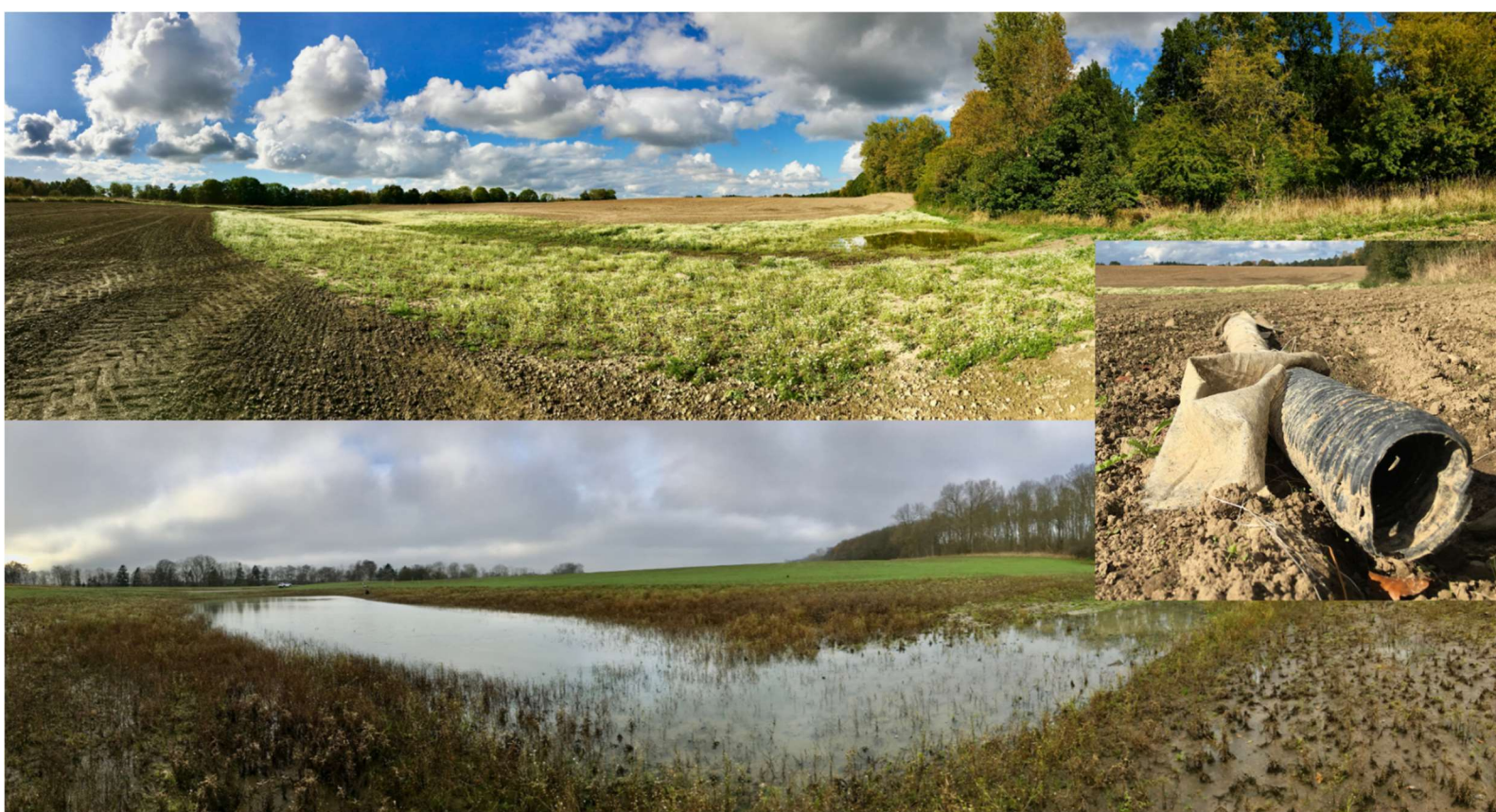
Søholt Storskov på Lolland er et eksempel på genopretning af et naturligt vådområde, både oven på og nede i jorden. Det øverste billede er før og det nederste billede er efter genopretning. Det lille billede viser et drænrør, der nu er gravet op, så dræning af jorden er stoppet og vandet kan flyde naturligt. Foto: Emma Røhmann Polauke.
